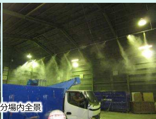
高所作業車での支持取り付け作業
