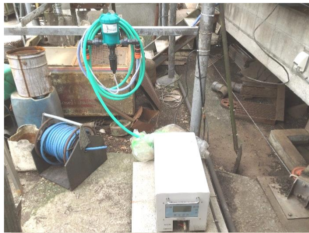
▲ 本体/混入器設置状況
