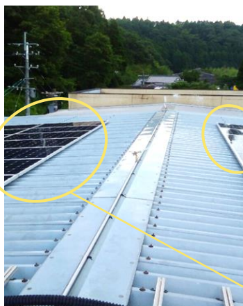
△ スプリンクラー設置状況
