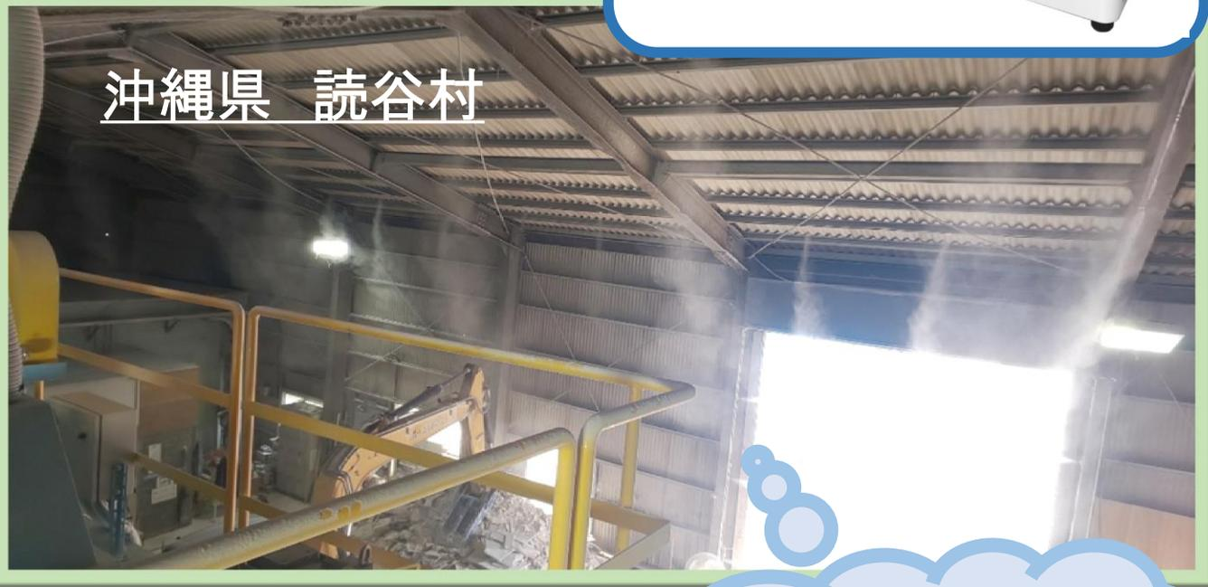
ノズル口径：0.15mm 50cc/min(7.0Mpa時)
