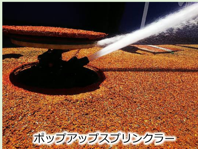
散水中の様子
