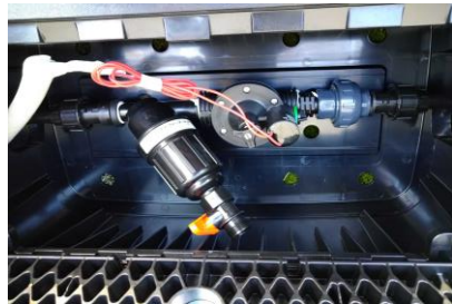
電磁弁ボックス
