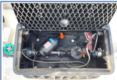
電磁弁ボックス
