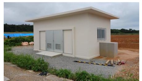
新しく設置された建屋
