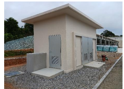
新しく設置された建屋
