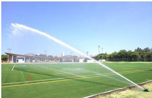
③散水距離40m程度 ポップアップSP
