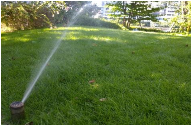
①散水距離10m程度 ポップアップSP
